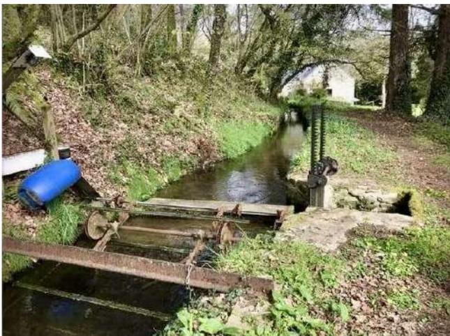
L'eau arrive jusqu'au moulin via un bief de 800 mètres, c'est à dire un canal de dérivation de la rivière. (Photo Ouest-France)
