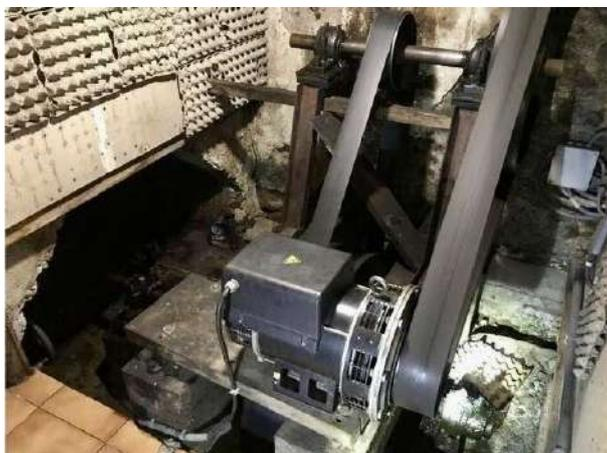
A l'intérieur de l'ancien moulin, la turbine entraîne la génératrice. L'énergie générée alimente les radiateurs de l'habitation. (Photo Ouest-France)
