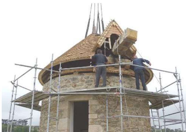
Mise en place de la coiffe du Moulin de Luzéoc
